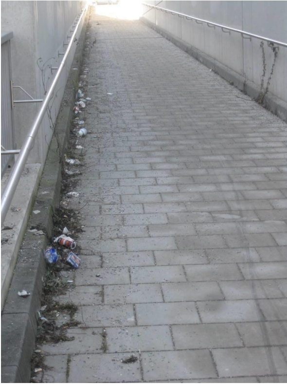
Freiham Bahnhof Südseite
