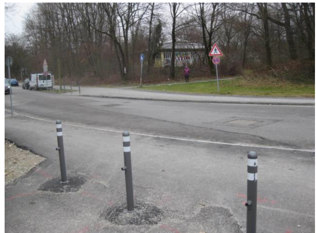
nördl. Fußweg mit Blick auf den bisherigen Überweg
