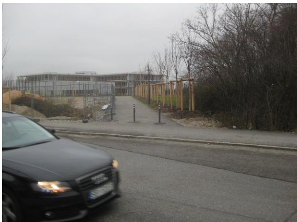
nördlicher Fußweg zur neuen Grundschule
